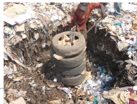
Ventilation system by discarded tires 廃タイヤを使った通気装置
