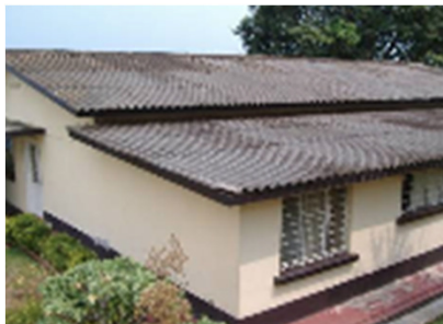
Asbestos cement roof in Rwanda ルワンダのアスベスト・セメント屋根
