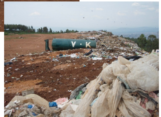
Extinguisher for methane gas explosion メタンガス爆発に備えた消火器
